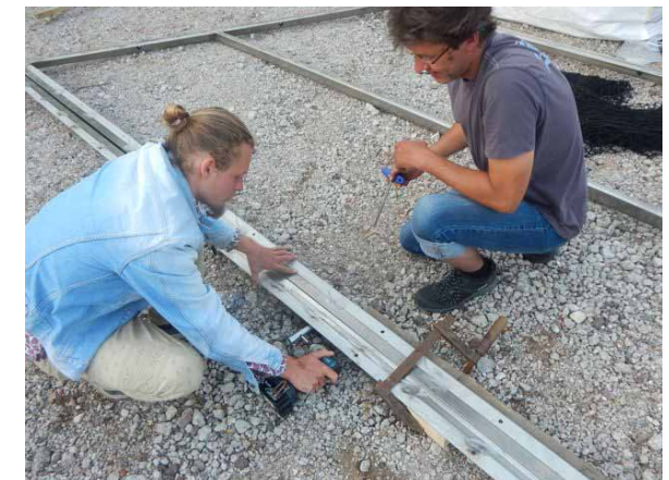
Auf diese Längen kann sich Rechteckrohr verziehen, sodass die Hälften zum Verschrauben evt. mit Schraubzwingen fixiert werden müssen.
