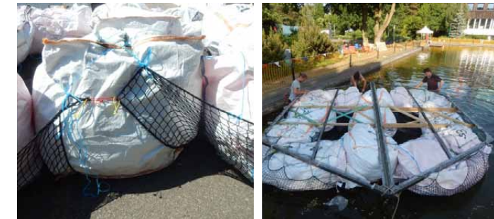
„HexaFloat“-Montage mit Transportnetz und zusätzlicher statischer Aufnahme (Holzbalken) der Auftriebskörper.
