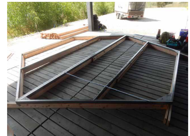
Zweiteiliger HexaFloat-Rahmen aus Edelstahl
